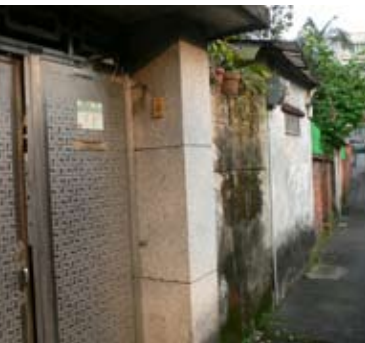
基地現況照片
